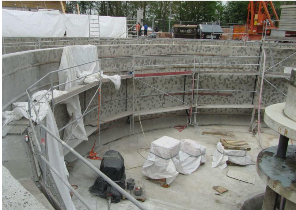
Abb. 1: Reprofilierter Lunker
