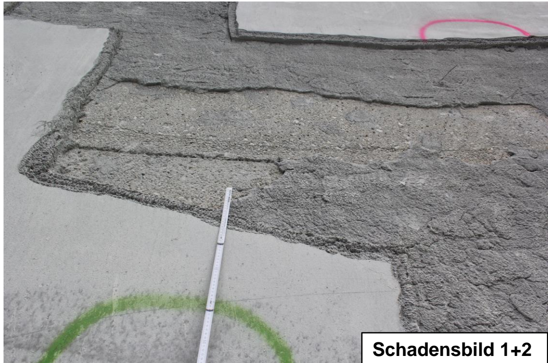
Abb. 7c: Unregelmäßiger Übergang der beiden Schadensbilder
