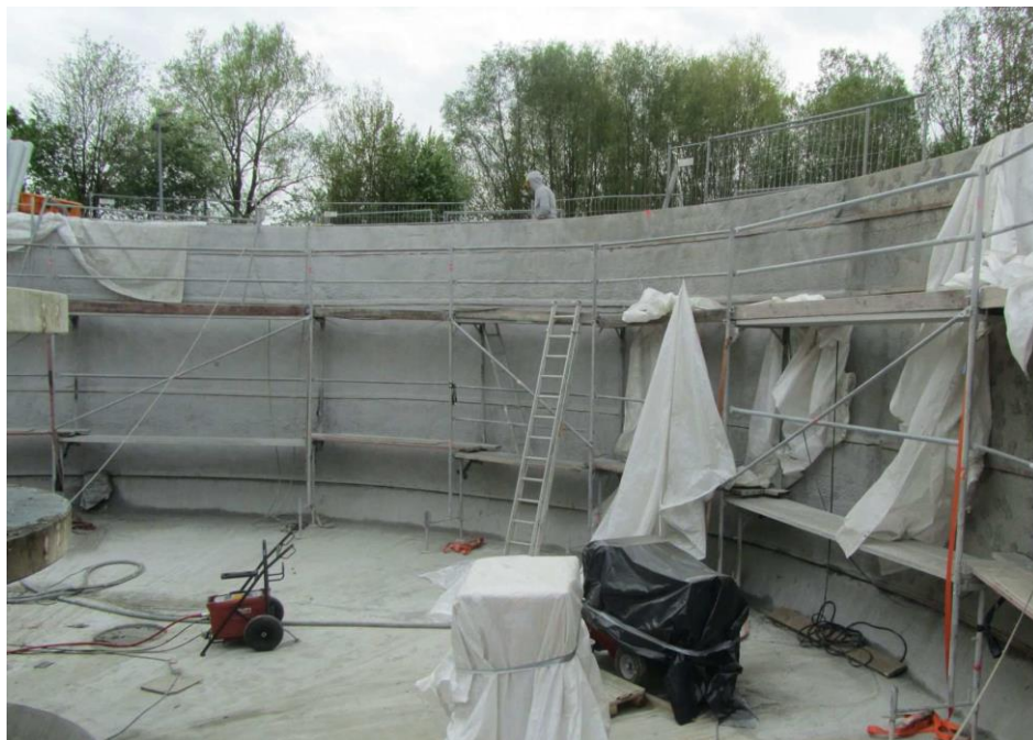
Abb. 3: Hellgraue, d.h. abgetrocknete, nicht nass nachbehandelte Spritzmörtelschicht
