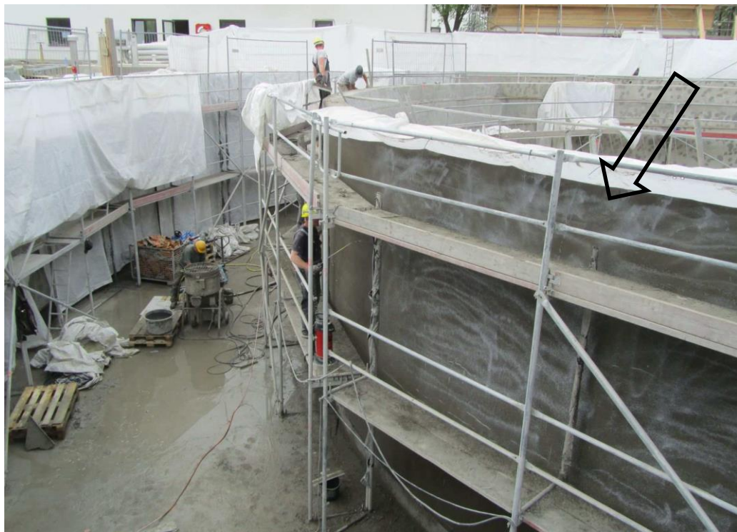
Abb. 2: Unsachgemäßer Auftrag des Nachbehandlungsmittels (Pfeil)
